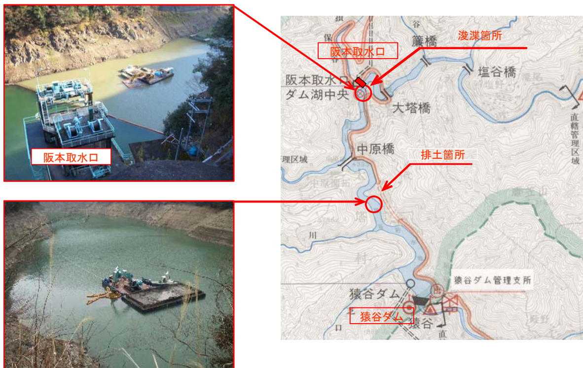
図 5.6-3 阪本取水口付近の浚渫の様子
