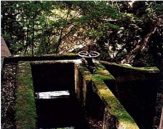
大江谷取水堰堤
