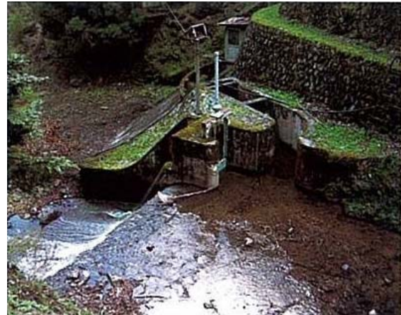
キリキ谷取水堰堤
